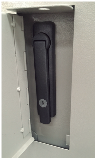
2. Cerradura de samac con cierre de 3 puntos.
